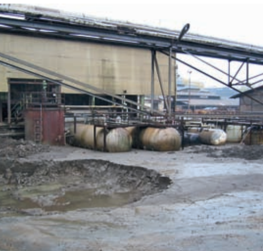
Die „blaue Lagune“ auf dem Werksgelände: Eine Auffangwanne für Chemikaliertanks und die angrenzenden Keller wurden mit Zinkschlämmen geflutet.
