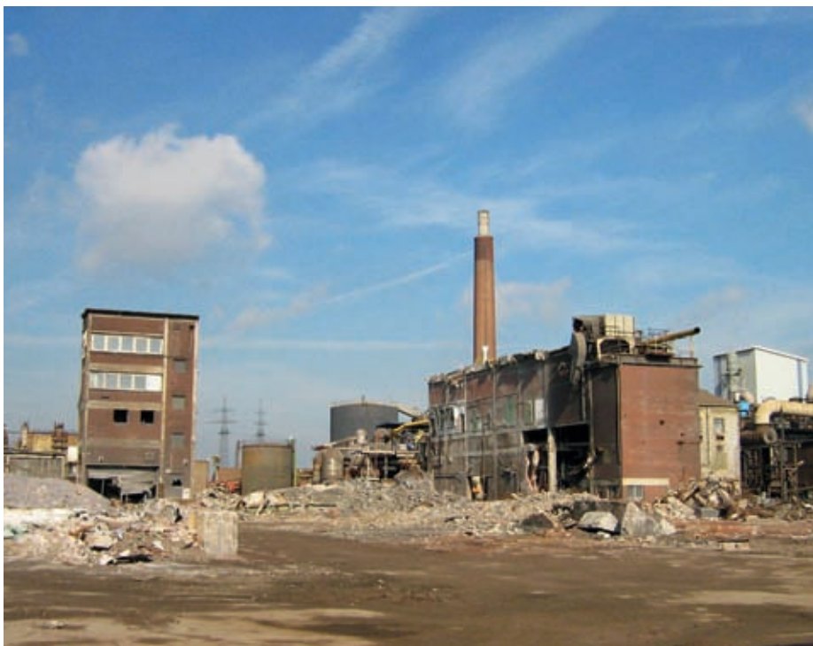
Die Räumung des MHD-Betriebsgeländes
