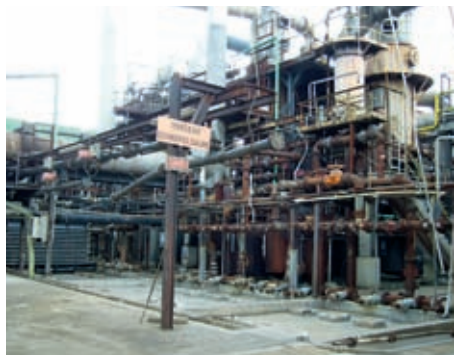
Schwefelsäureanlage mit Restfüllungen
