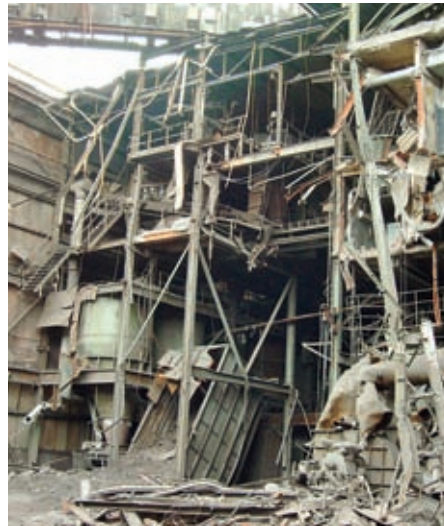
Abbruch der MHD-Anlagen
