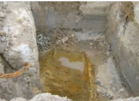
Altfundamente und belastete Verfüllungen auf dem Werksgelände
