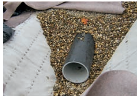
Anlage der Drainagegräben zur Entwässerung der Deponie
