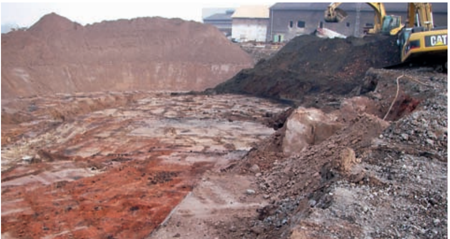
Sanierung der Schlackenanfüllungen auf dem Werksgelände
