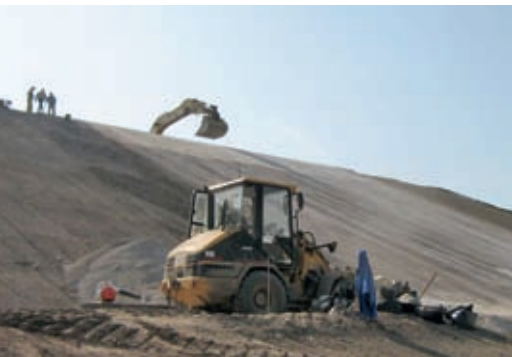
Fertigstellung und Schließung der MHD-Werksdeponie
