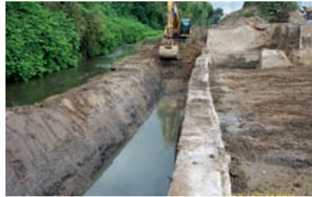
Sanierungsarbeiten zur Anlage des Angerbachweges
