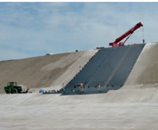
Bau der Deponieabdichtung mit Kunststoffdichtungsbahnen (KDB)
